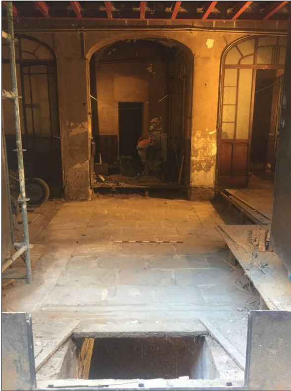
Foto 03. Entrada original de la finca.
