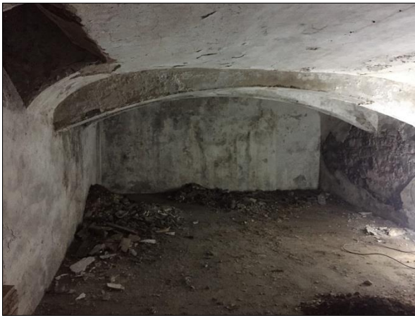
Foto 05. Estat inicial del soterrani
