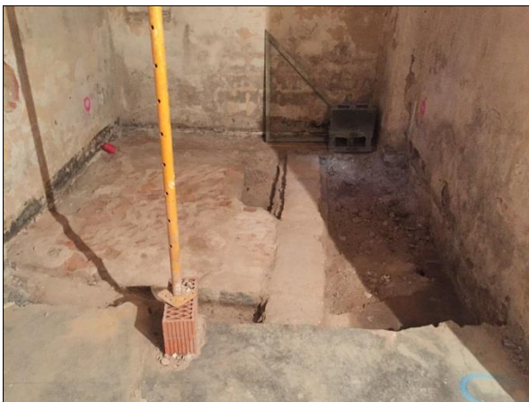
Foto 14. Estat inicial sota el paviment de ciment UE 20
