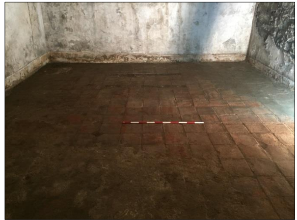
Foto 06. Paviment original de la finca (UE 4)
