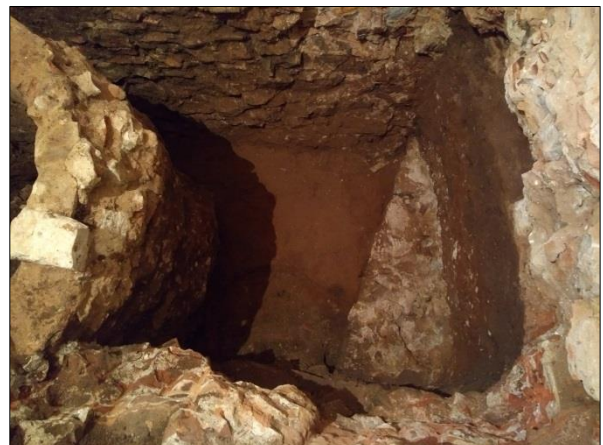
Foto 27. Estat final. Vista cenital. A la dreta la fonamentació UE 39
