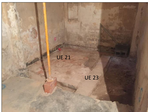
Imatge 7. Estat inicial sota paviment actual
