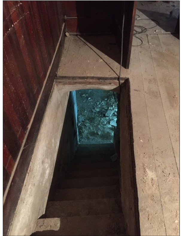
Foto 04. Escales d'accés al soterrani
